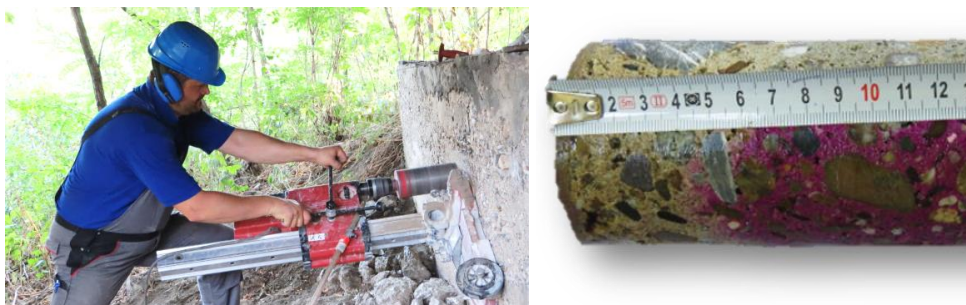
Obr. 2) Odber vzoriek betónu (vľavo), meranie hĺbky karbonatizácie betónu (vpravo)
